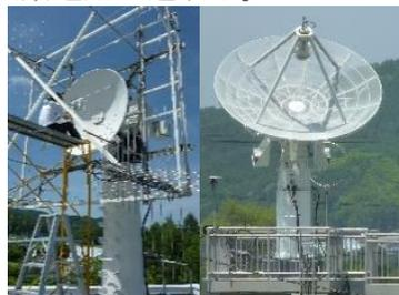
図9: 衛星追尾用パラボラアンテナ
