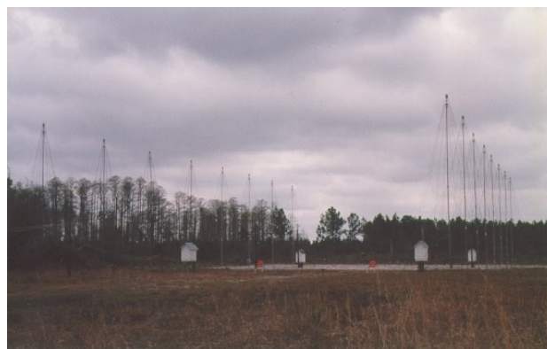
図 4 フロリダ大学のログスパイラルアンテナ
